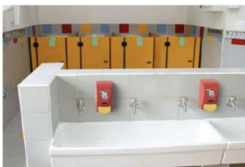
Fotografia: exemple d'instal·lació de piques. Interior.
